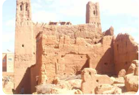
• زحف البناء الإسمنتي وتراجع البناء التقليدي
