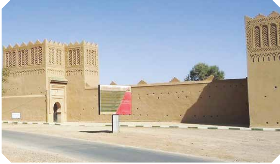
الصورة 9: الباب الأول لقصر أولاد عبد الحليم بعد عملية الترميم
