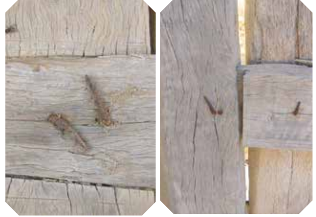
تقنية الربط عن طريق الحز
