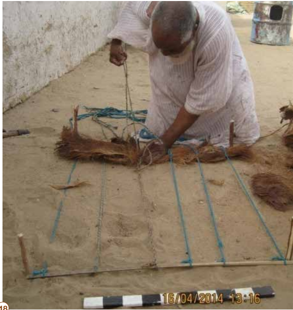
طريقة ربط أوَّل لفافة من اللَّيْفِ، بفك طرف الحبل المعقود على الجريدة واستخدامه لربط اللِّفافة على الحبل المشدود من أسفل، بطريقة رَمْلُ الجريد في سقوفات المنازل
