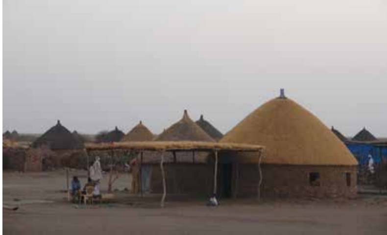
الشكل النهائي لبناء القطية مع الراكوبة التي يتم بناءها من أمام القطية.
