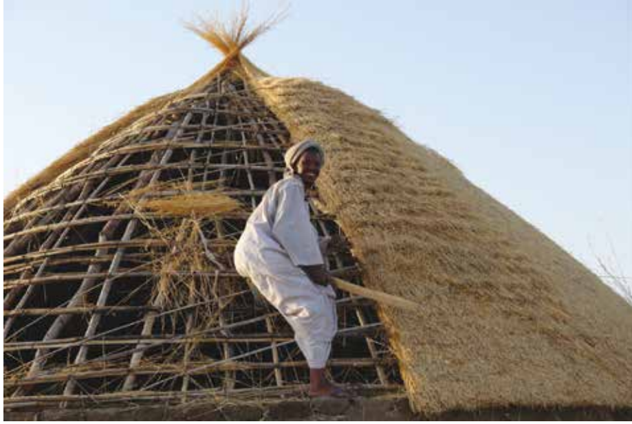
طريقة نسيج القش باستخدام أداة المُنْقَالَة الخشبية .
