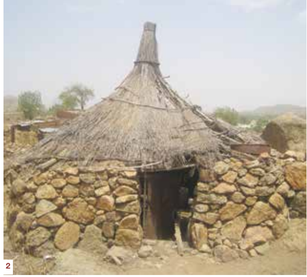
شكل البناء بمادة الحجارة والطين، والسقف من القش الذي يأخذ الشكل المخروطي.
