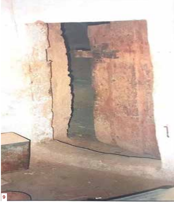
يوضح خطوات ومراحل عمل البناء لمسكن الطين تبعاً. باب مصنوع من جذع النخل بالبلدة التاريخية (الديرة)، (الإمام محمد: 2020م).
