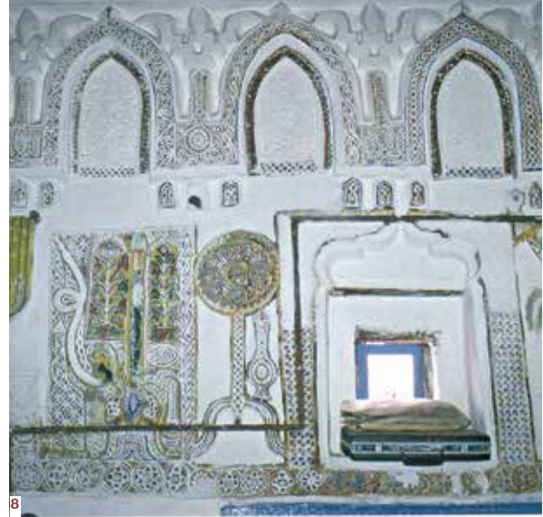
ألوان على أجزاء من التشكيلات الزخرفية في جدار الواجهة الداخلية وفيها سيوف ومعاشروشمعدانات.
